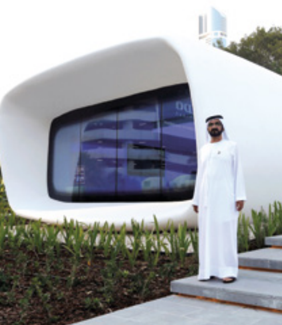
Dubai: Das erste Bürogebäude aus dem 3-D-Drucker, entworfen in Österreich, gedruckt in den USA und den Vereinigten Arabischen Emiraten.
